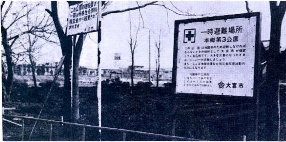
公園整備の現場
